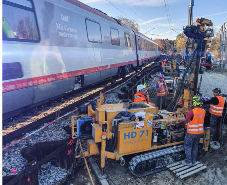
Abbildung 4: Bahntrasse durch Spundwände gestützt (Beilage ./3b)
