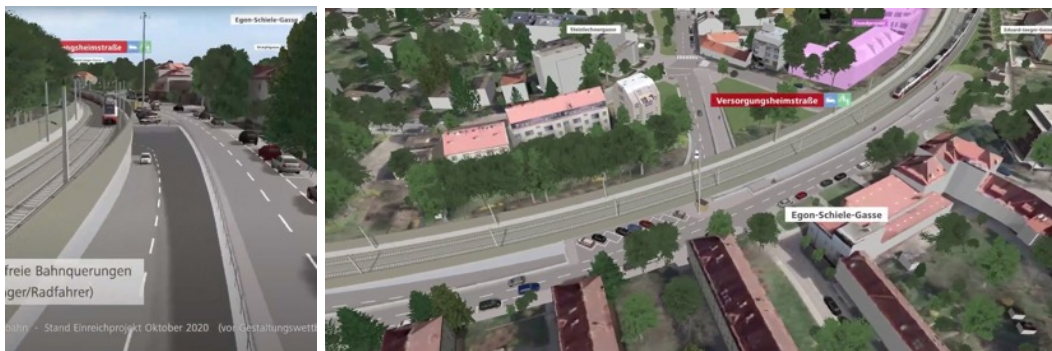
Abbildung 2: Mediengalerie ÖBB 1 – Videoausschnitte Unterführung Versorgungsheimstraße
